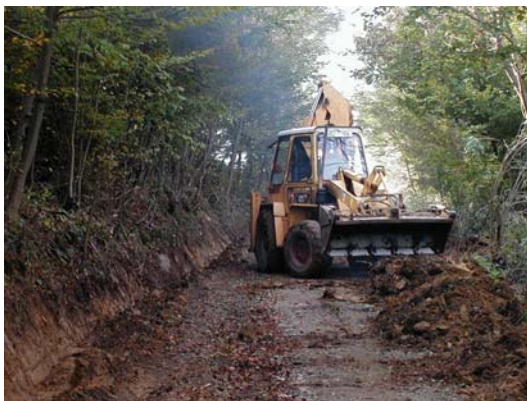
Izgradnja puta do sela Komarica.
