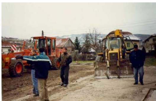
Radovi na izgradnji sportskog terena u selu Haljinići, Kakanj.
